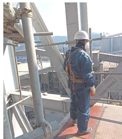
[사진 9] 안전대 체결 예시(작업반장)
