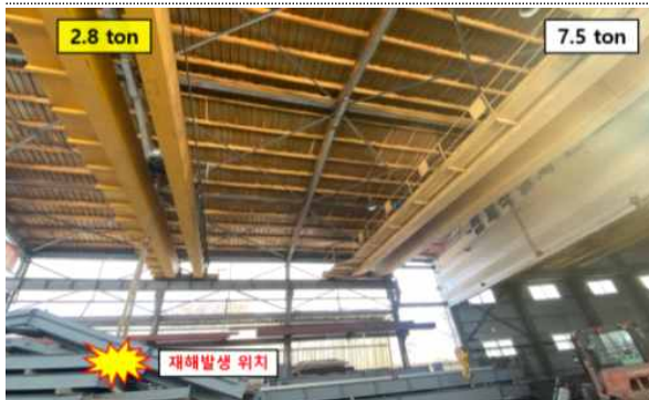
[사진 12] 천장주행크레인 설치 상태
