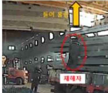
H-beam 위의 고임목을 크레인로 들어 올리는 재해자
