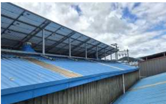
[사진3] 해체 예정인 지붕 채광창 전경
