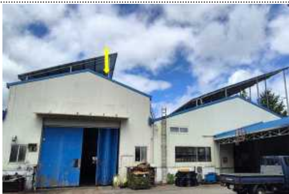
[사진1] 재해발생 공장 전경
