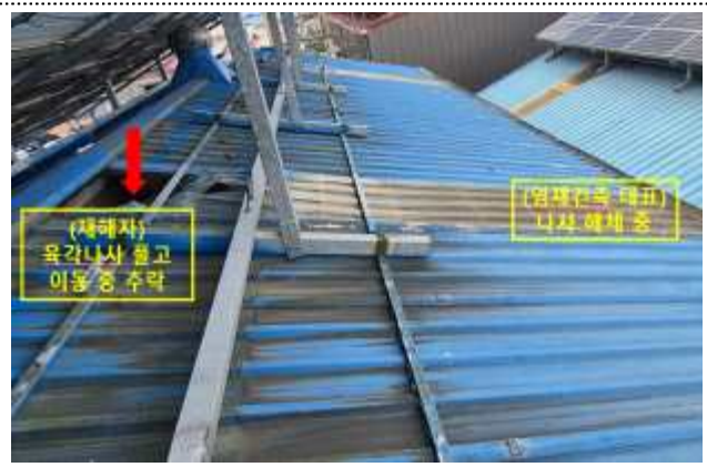
[사진6] 재해발생 시 PC 패널 작업구간
