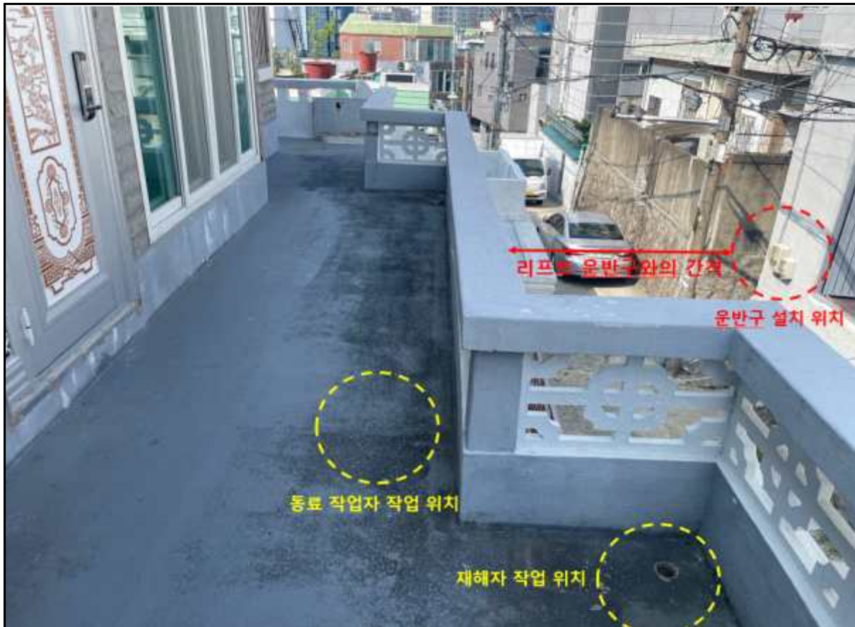
[사진16. 리프트 운반구 설치 위치 및 재해발생 시 작업자들의 작업 위치]
