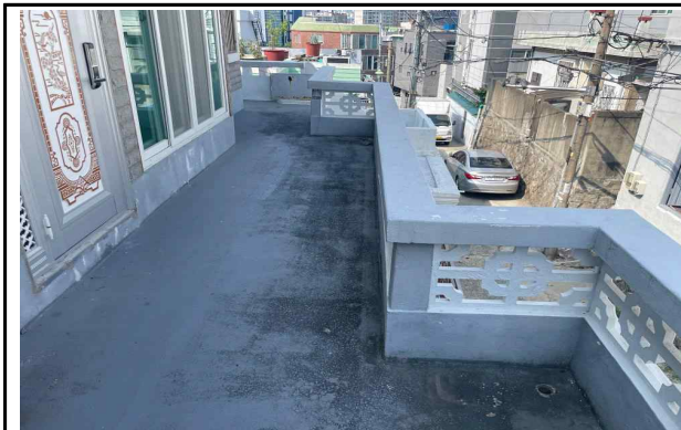
[사진3. 2층 출입문 앞 난간]
