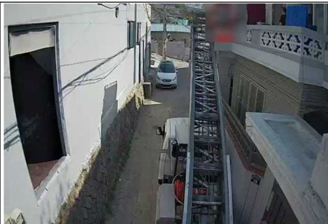
[사진6. 냉장고를 운반구에 올리기 위해 난간과 운반구 위에 올라간 재해자(CCTV 캡처)]
