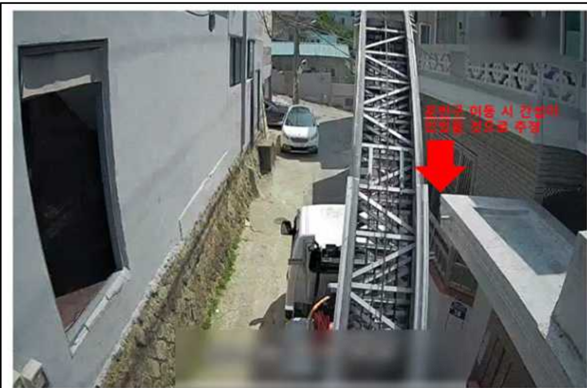
[사진15. 처음 리프트 운반구 설치를 시도한 위치(CCTV 캡처) ]
