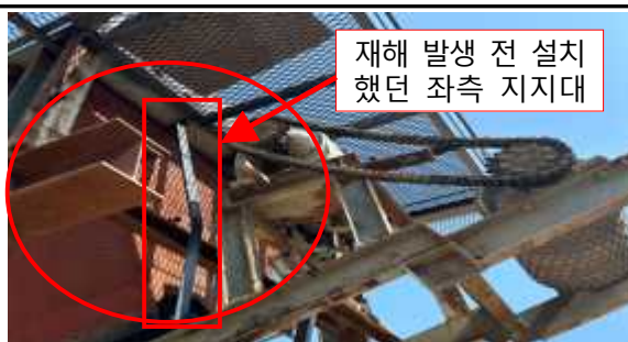
【사진7】 동료작업자(C) 작업위치 및 지지대 고정 사진
