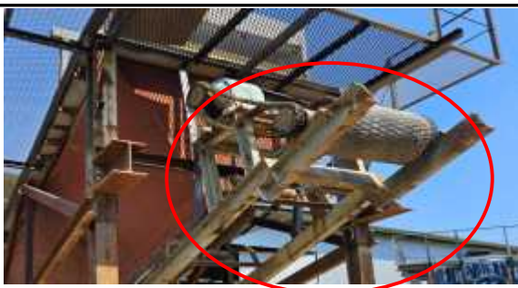
【사진4】 컨베이어 상부 프레임
