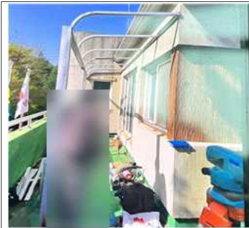
[사진#1] 하지철물 작업 당시 재해자가 찍은 사진 (2024.4.30.)
