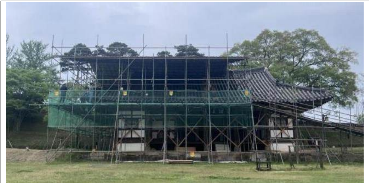
[사진1] 현장 전경
