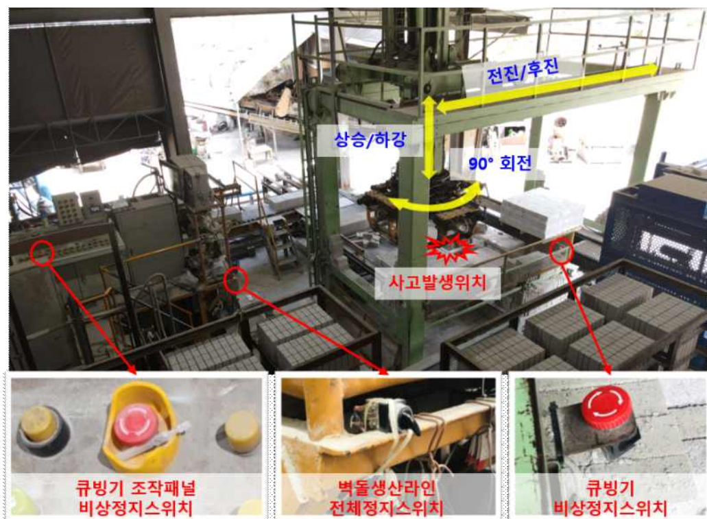
[사진 5] 사고 발생 지점 및 비상 정지 스위치 설치 지점
