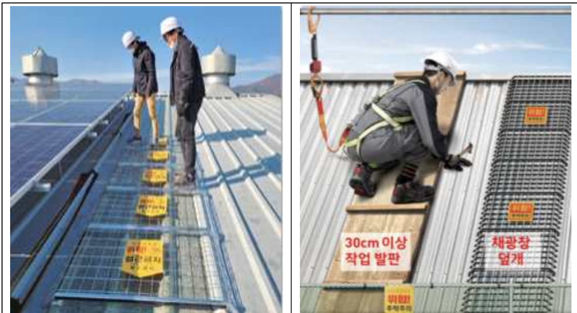
채광창 덮개 설치 등 안전작업 예시
