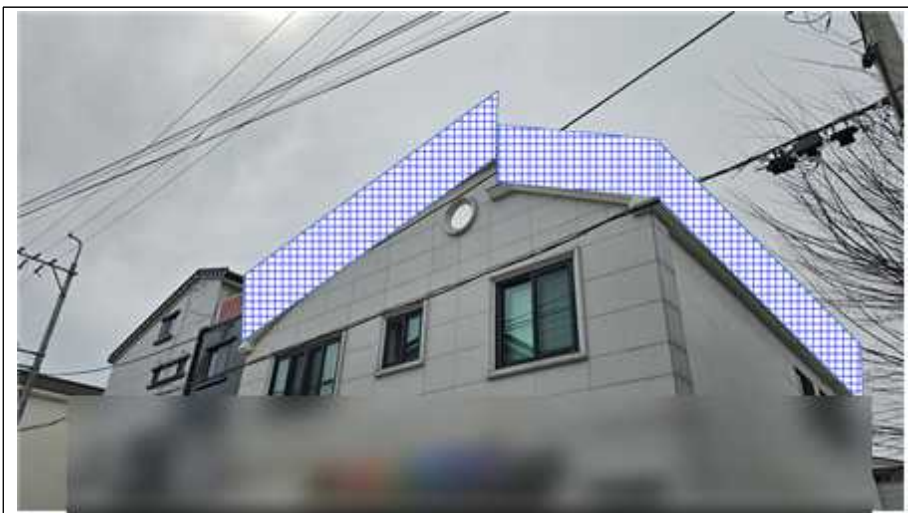
【사진 7】 안전난간 설치 예시
