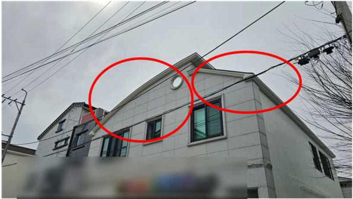
【사진 1】 작업현장 전경(지붕)
