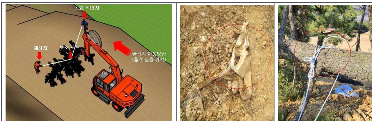
[그림5] 소나무 이동방법과 소나무를 묶은 슬링 벨트 및 보조로프
