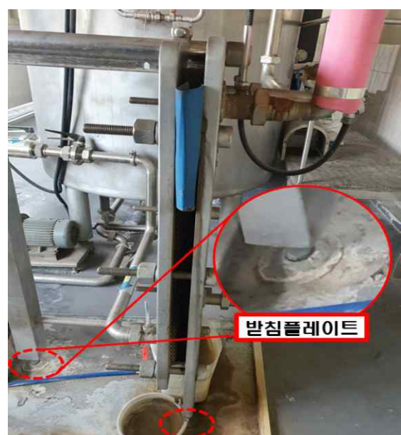
[사진6] 해체된 열교환기*기인물(작업 전 사진)
