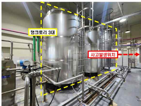
[사진1] 제작·설치 된 탱크로리 3대
