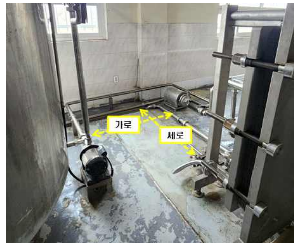
[사진9] 작업장소 사진
