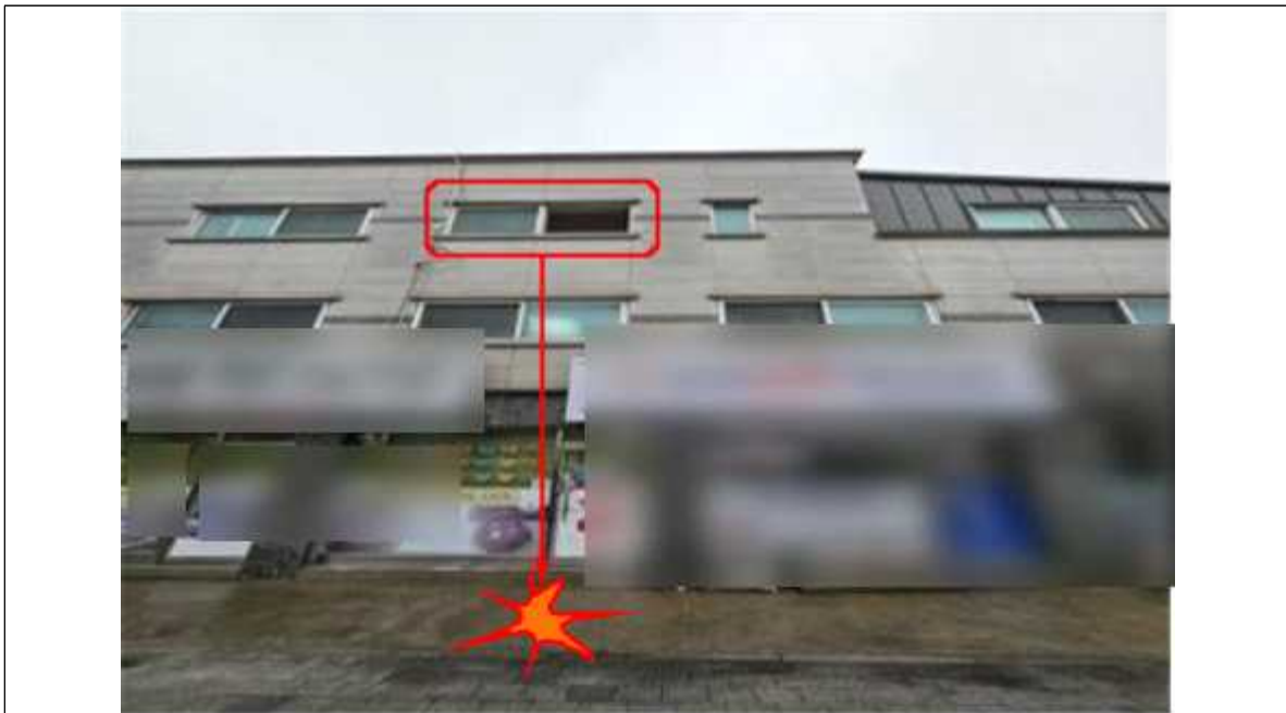
[사진1] 사고현장 전경(지상 높이 약 7.9m)
