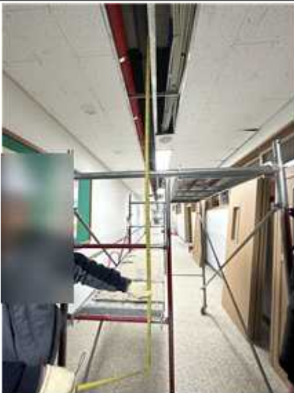
[사진5] 천장과 작업발판간 높이 측정
