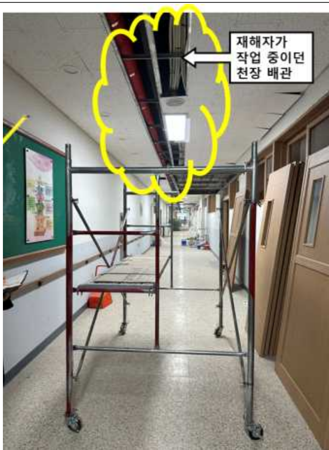
[사진1] 현장 전경
