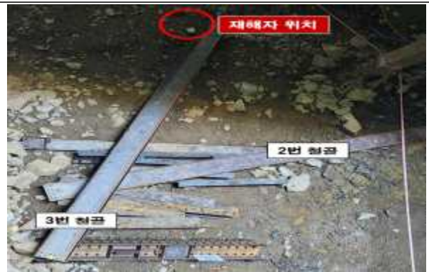
【사진 4】 지하 5층 굴착면
