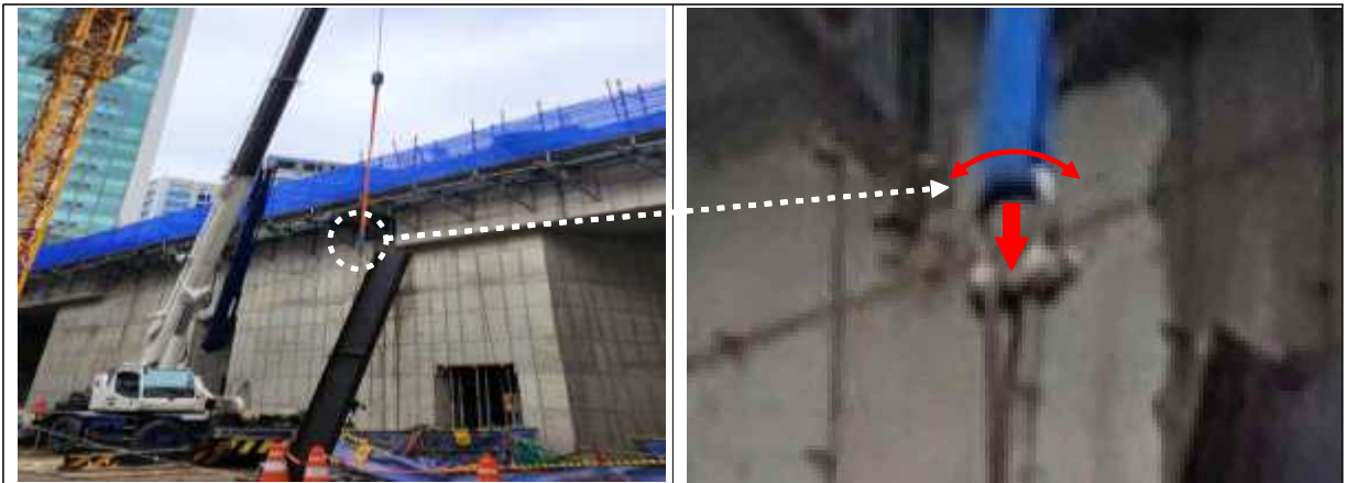
【사진 7】 1번 철골 라운드슬링 고리 샤클 연결 현장재현('24.2.6)
