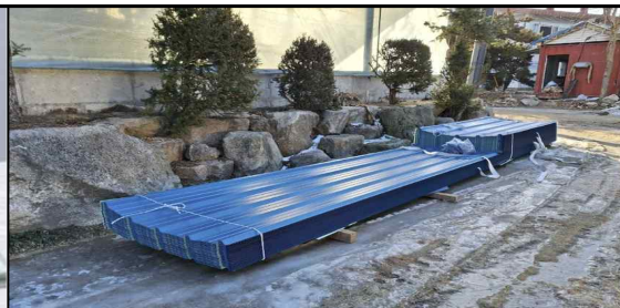
【사진 4】 축사 지붕 위 선라이트(채광판) 덧씌우기용 강판
