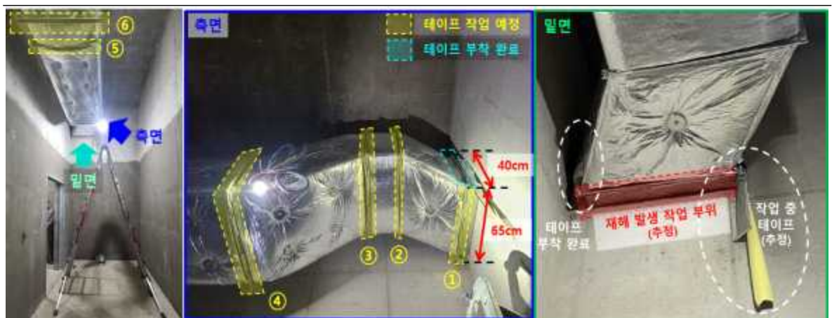
제연덕트 이음부 마감 작업 현황(알루미늄 점착 테이프 부착)
